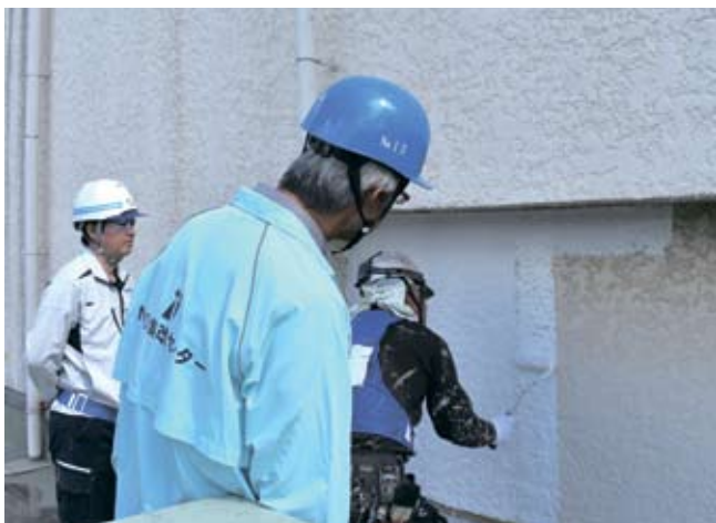
まずは通常のローラーでテスト施工
