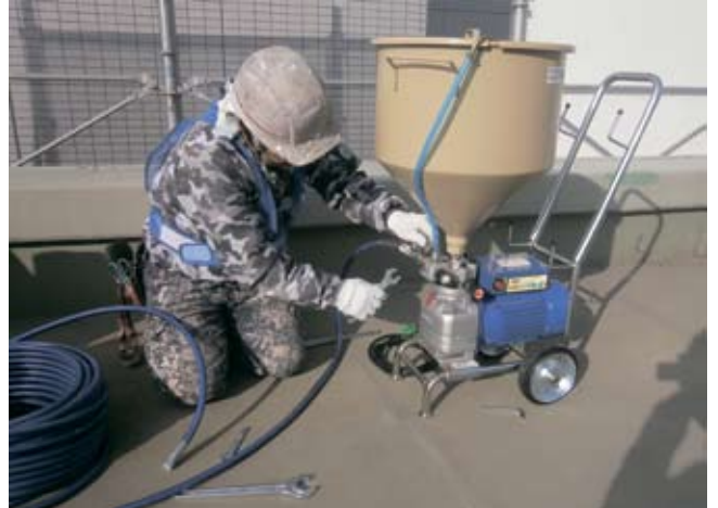
塗装機に圧送ローラー用ホースを装着
