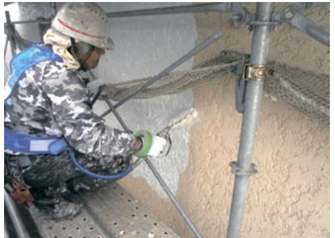
圧送ローラーによる塗装作業
