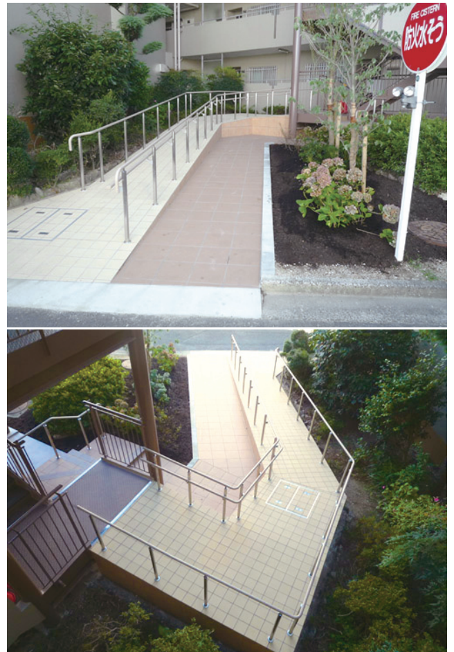
玄関スロープの施工例
