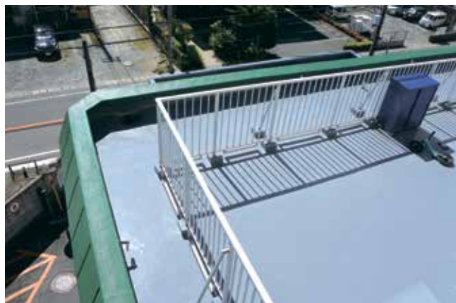
屋上は防水シートに変更
