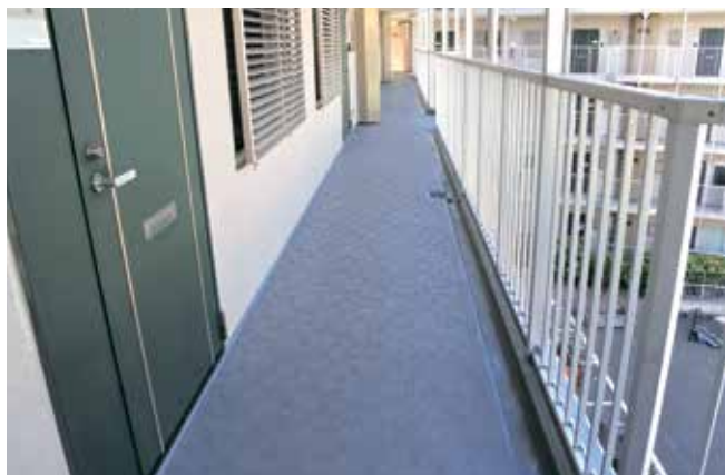
廊下のシートを貼り替え
